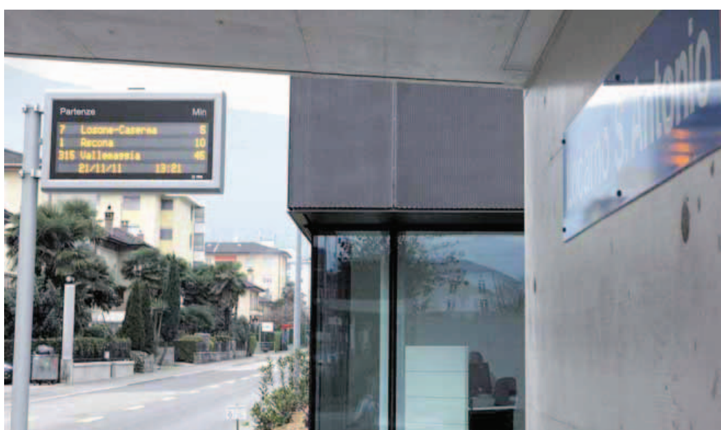
QUANTO MANCA? Il tabellone installato in prova in via Galli, con l'indicazione dei tempi di attesa. (Foto Garbani)
